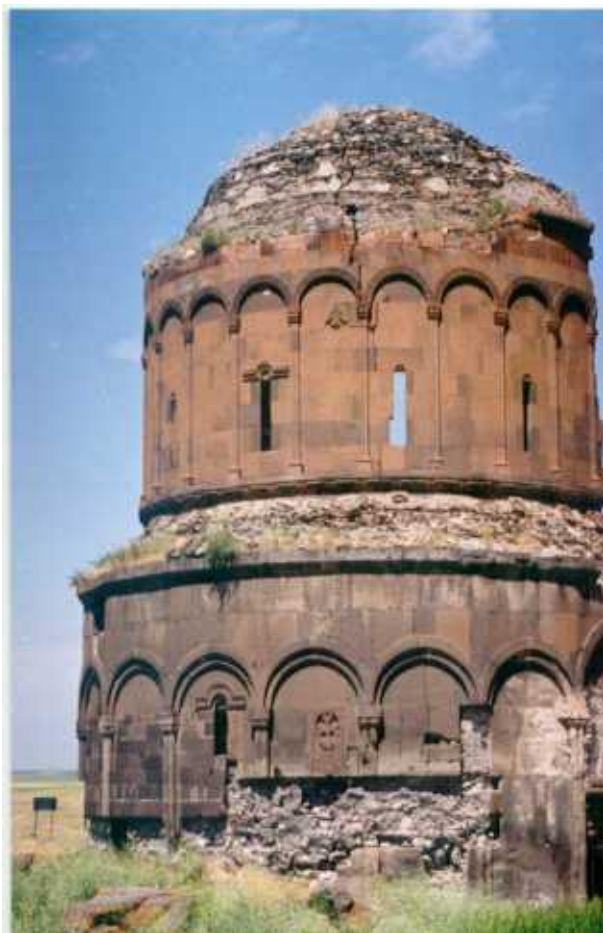
Figura 8 Ani, chiesa ottoconca del Redentore, opera di Trdat, realizzata verso il 1036, che si ispira alla chiesa di Zvart'nots , nella superposizione di cilindri di diametro decrescente , coronati in Zvart'nots da un cupola a tetto conico, secondo la ricostruzione di Thoramanean
