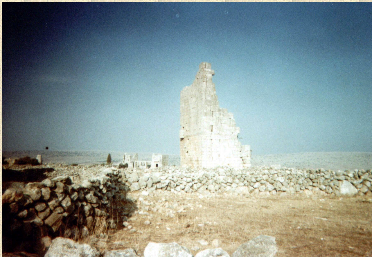
Figura 54 Casa torre in Refade
