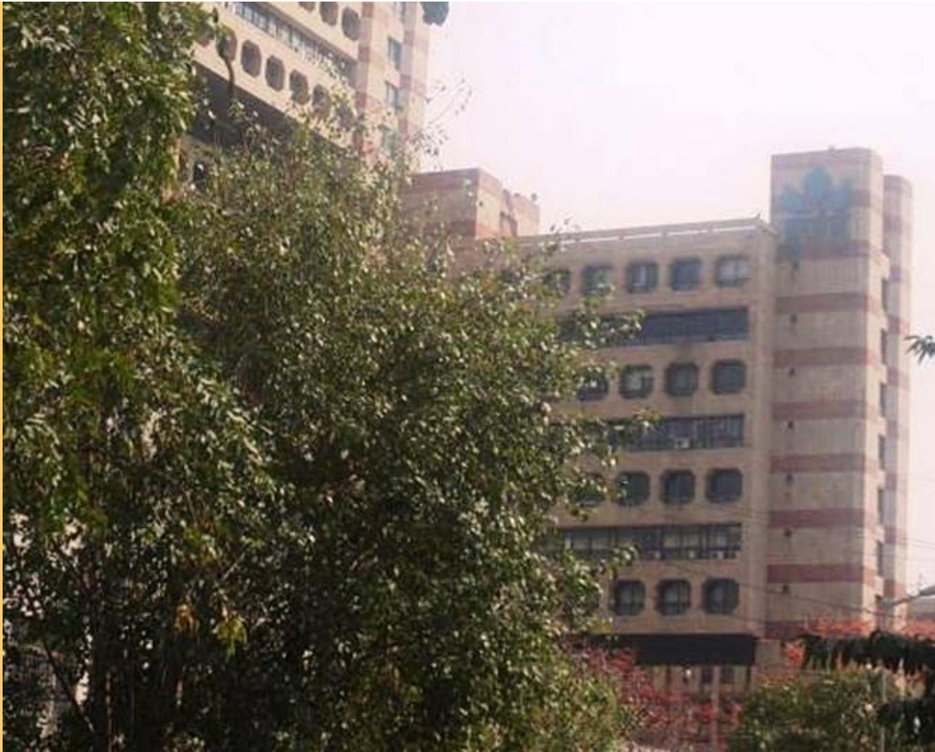
e su due trasversali,- una delle quali è solo di supporto mediano, e scarsamente visibile, - che formando due bracci, ad essa sono connesse da possenti travi Vierendeel, a piani alterni, la cui sporgenza enfatizza come la modernità tecnologica vi abbia esaltato la derivazione dell'architettura in pietra indiana da quella lignea, mediante la tecnica dell'incastro di elementi che vi è ciclicamente macroscopizzata.
